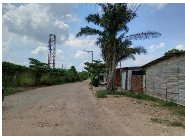
Construcciones en predio invadido
