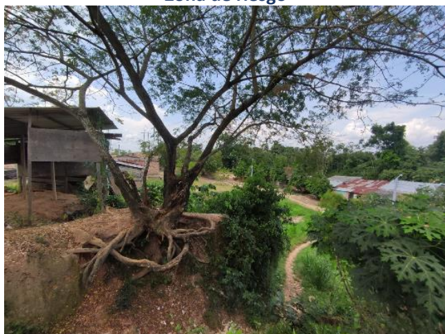
Zona de riesgo
