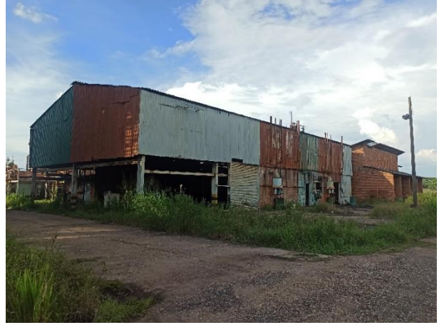
Planta de Amoniaco con Fachada Metálica
