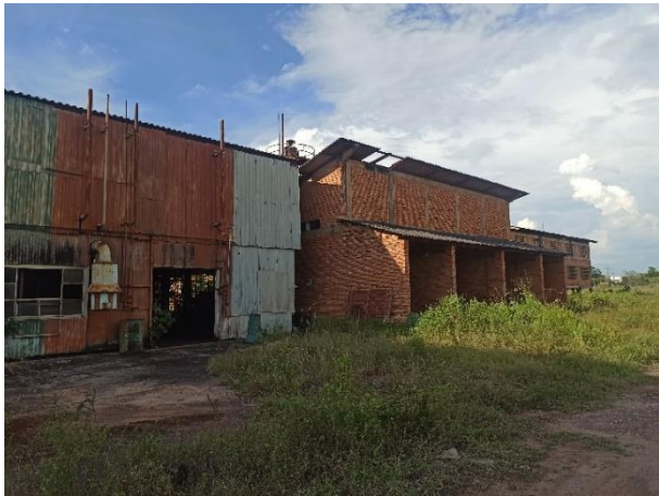
Planta de Amoniaco con Fachada en Ladrillo
