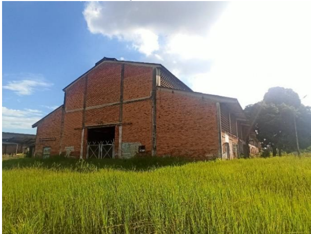
Edificio de Mantenimiento
