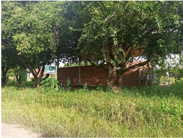
Construcción Cubierta Bomberos
