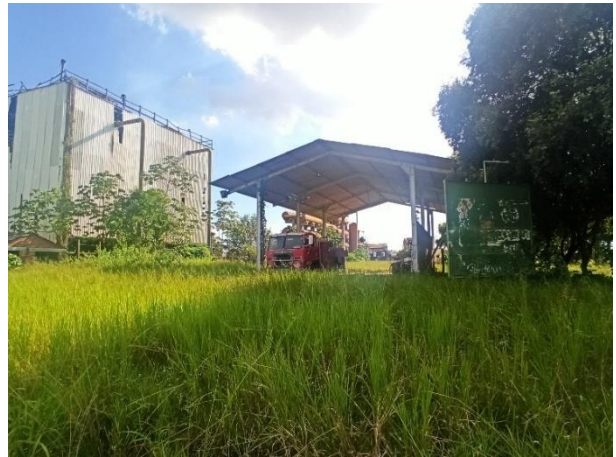
Construcción Cubierta Bomberos
