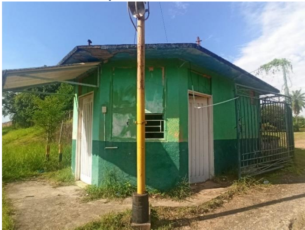
Caseta portería interior
