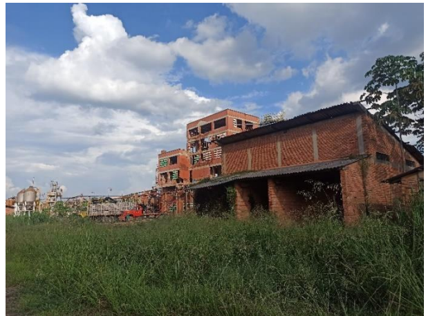
Construcción Colindante Planta de Urea 2
