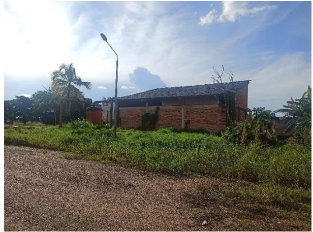
Construcción Colindante Planta de Urea 1
