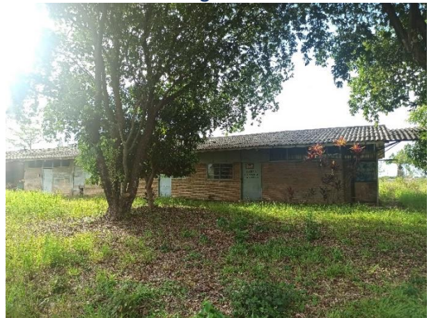
Oficinas de Seguridad Industrial
