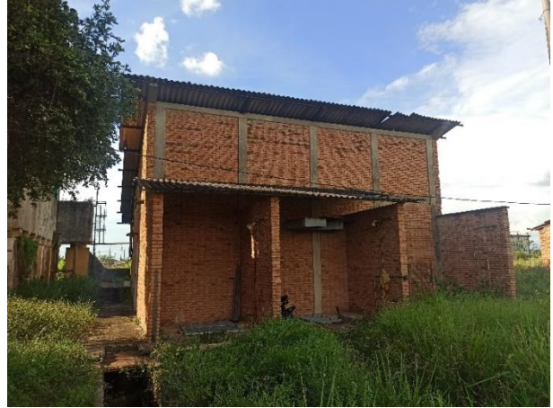
Bodega Colindante a Torres de Enfriamiento
