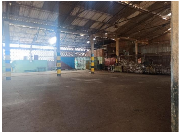
Bodega Principal de Almacenamiento
