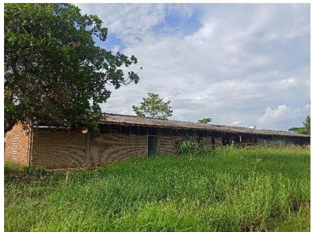
Oficinas de Seguridad Industrial
