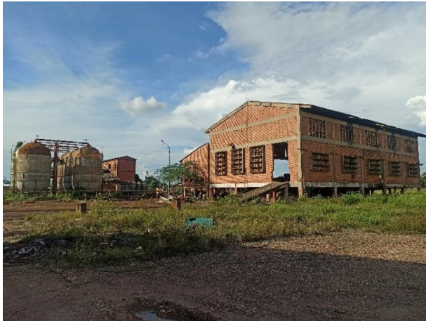
Bodega Colindante a Planta de Amoniaco
