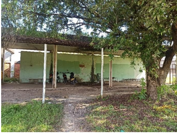
Parqueadero de Motos
