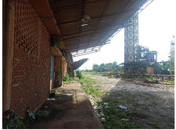
Bodega Principal de Almacenamiento
