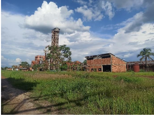
Construcción Colindante Planta de Urea 1
