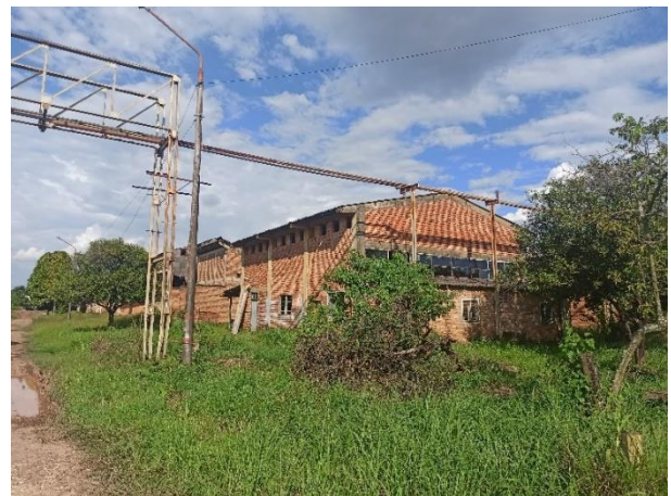
CONSTRUCCIÓN COLINDANTE EDIFICIO DE MANTENIMIENTO 1 Y 2
