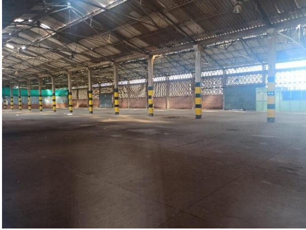
Bodega Principal de Almacenamiento
