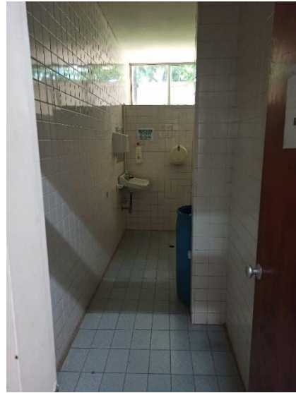
Baños - Edificio Administrativo
