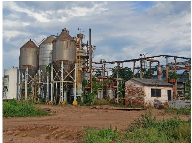
Planta de Agua
