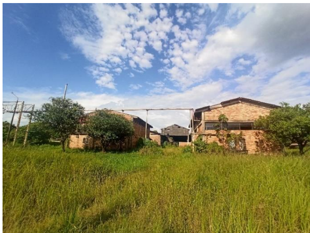
CONSTRUCCIÓN COLINDANTE EDIFICIO DE MANTENIMIENTO 1
