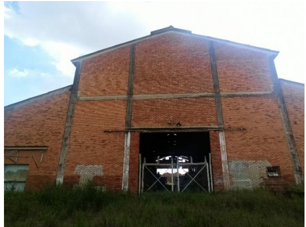
Edificio de Mantenimiento
