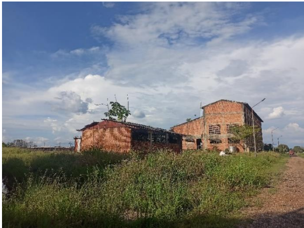
Construcción Colindante a Torres de Enfriamiento
